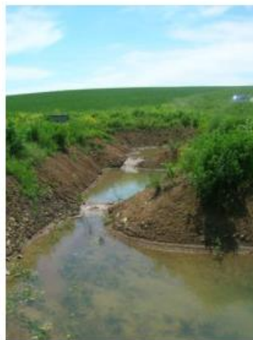
Figure 6 : Dispositif « linéaire en trois bassins »
