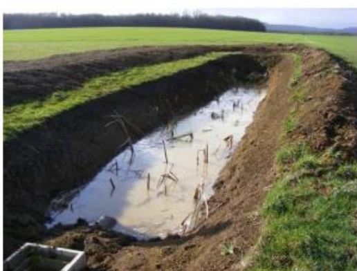
Figure 3 : Dispositif « fossé court re-végétalisé »
