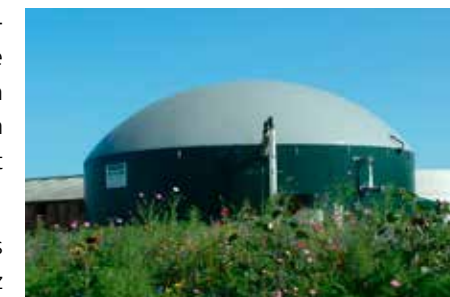
Recyclage du méthane en énergie
