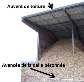
Il faut une dalle bétonnée propre au moment d'y apporter les plaquettes.
