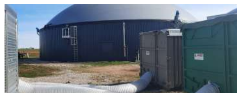
Caisson de séchage utilisant la chaleur produite par l'unité de méthanisation en arrière-plan.
