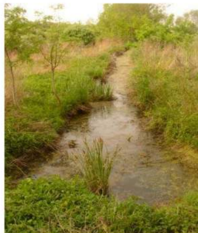
Fossé végétalisé La Chapelle de Guinchay
